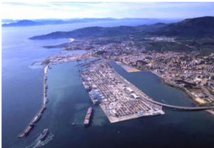
Dique paralelo a la costa
